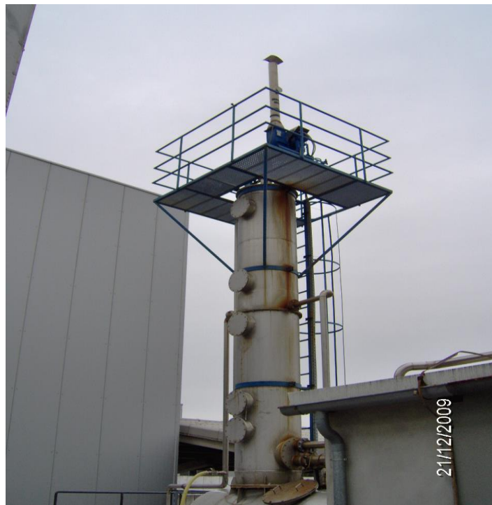
Slika 18: Mokri pralnik zraka, kjer se čistijo emisije hlapnih organskih spojin (HOS). Predlagane so nekatere izboljšave, ki bi lahko izboljšale delovanje pralnika.
